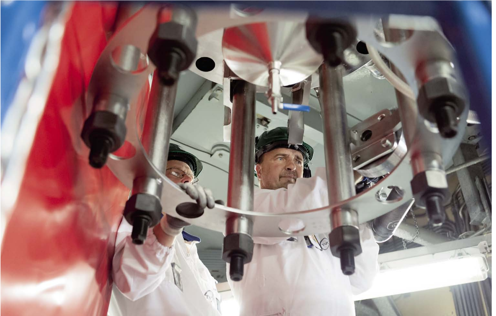
Olkiluoto kakkosen pääkiertopumpun asennustöissä Caverionin Jari Tähkänen (vas.) ja Mika Pihlajamäki.
