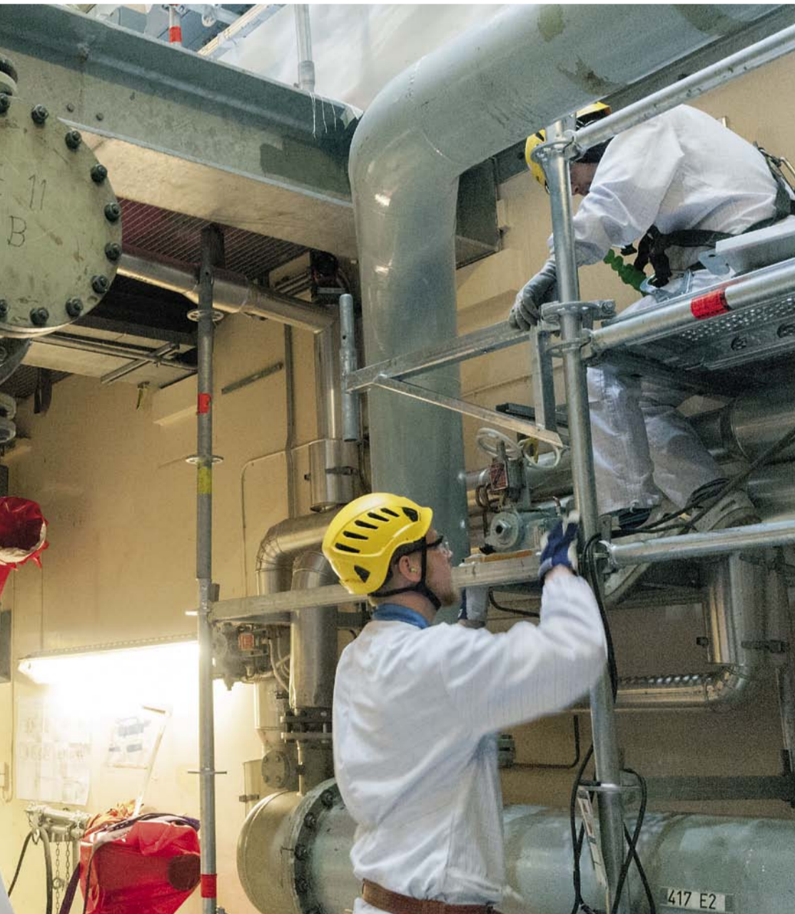
Asentajat tarkistavat lauhduttimen merivesipuolen tekniikkaa.
