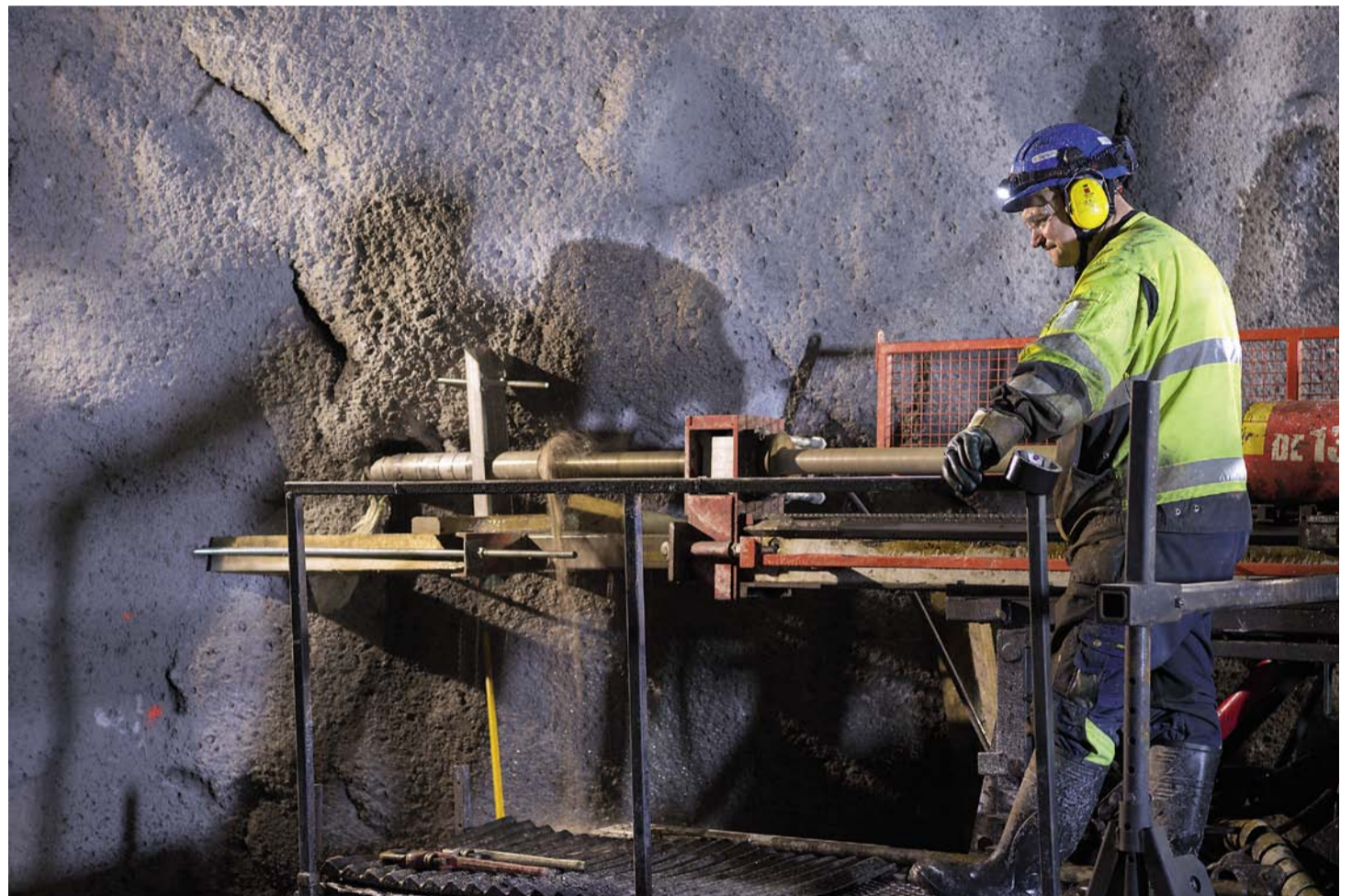
Huhtikuussa ONKALOSSA kairattu pilottireikä on pituudeltaan yhteistoimintakokeen keskustunnelin mittainen, noin 60 metriä
